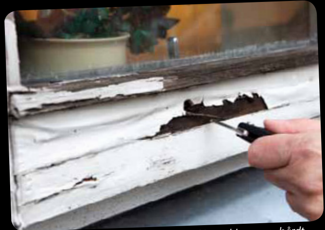
Både vinduesrammer og det nederste af hoveddørene er hårdt ramt af råd.
