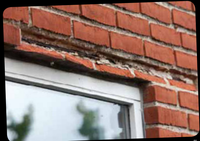
Stålarmeringen over vinduerne sprænger overliggerne næsten alle steder i Hasselhøj.
