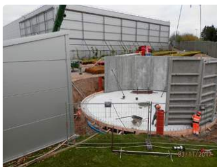
Montering af elementer i efterklaringstank.
