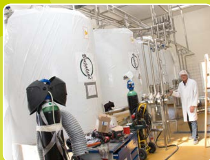
Det nye CIP-anlæg fungerer som vaskemaskine til tanke og rør. Anlægget skyller, vasker, syre-rengør og skyller de mange dele.
